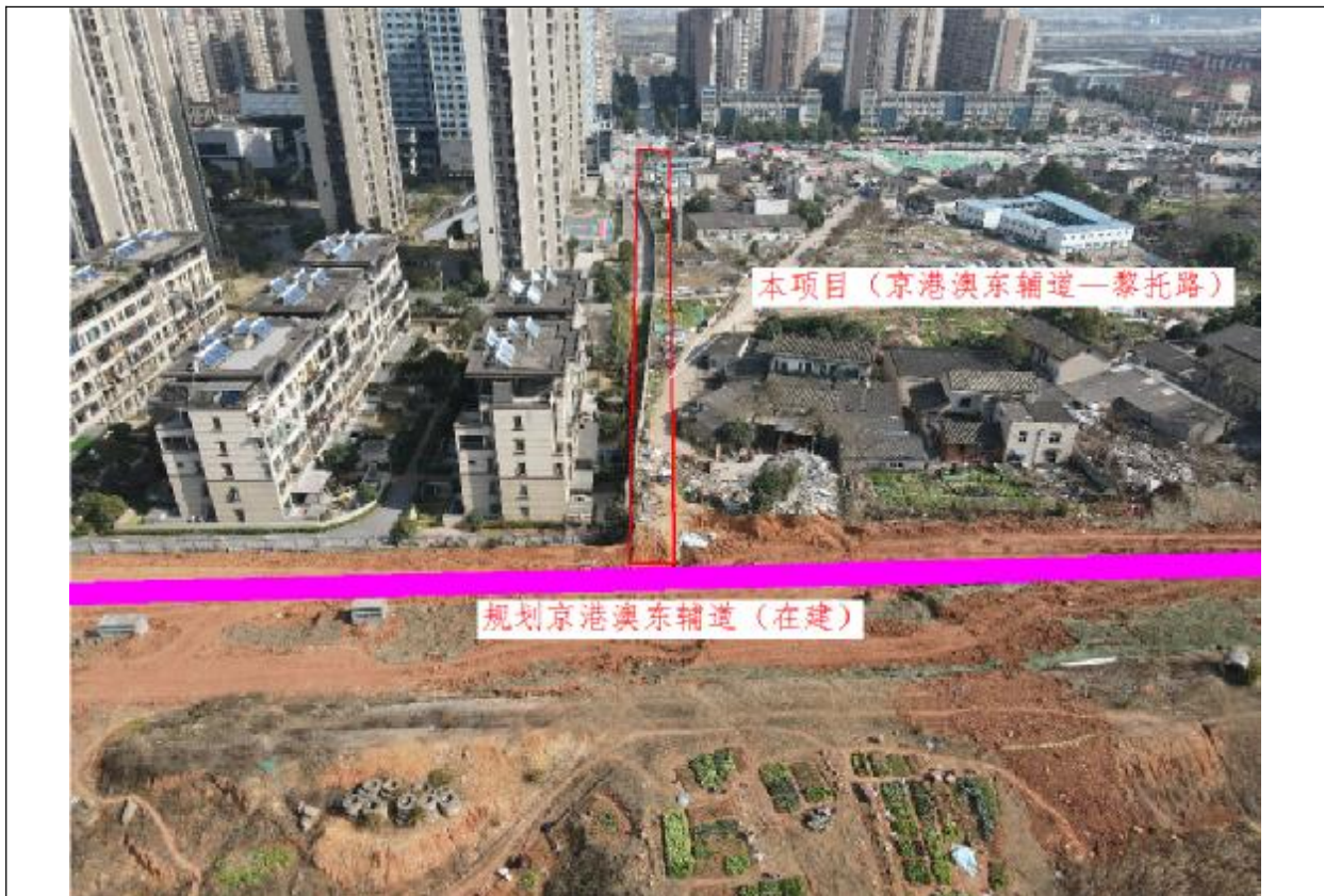
本项目（京港澳东辅道—黎托路）段现状
